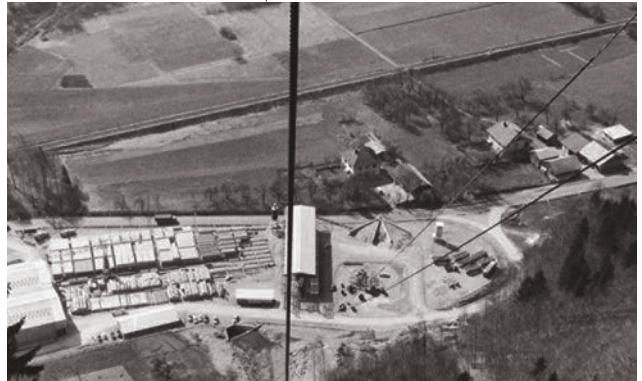
L'usine de préfabrication à Magland, vue depuis le téléphérique (© G. Carrard et M. Vardon/Centre Pompidou)
