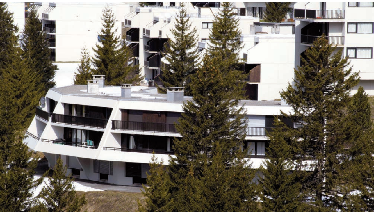
Immeuble Les Grands Vans, G. Chervaz, architecte (R. Bianchi/CAUE 74)
