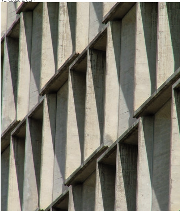
1, 2 & 3 : Hôtel Les Lindors, détails des fenêtres à caissons et panneaux en pointe de diamant. (G. Coquard/CCF)
