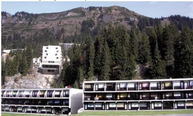
Flaine Front de Neige, vue générale des façades (CAUE 74)
