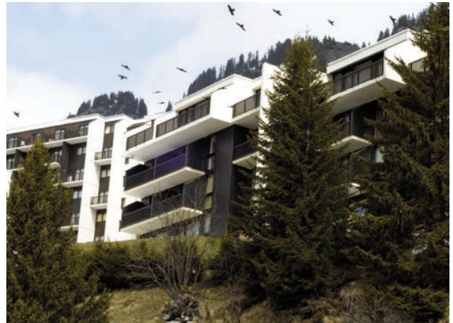
Façades rénovées à Flaine Forêt (R. Bianchi/CAUE 74)
