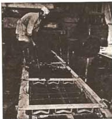
Des résistances électriques sont fixées sur les armatures et seront noyées lors du coulage; leur échauffement portera l'élément à une température qui accélérera la prise du béton.
