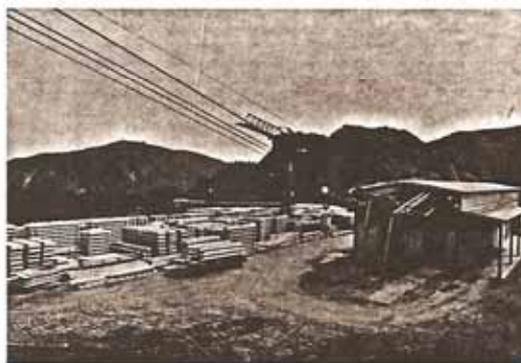
L'aire de stockage est desservie par une grue-tour. Les éléments nécessaires à l'avancement du chantier pendant une semaine sont entassés ici.
